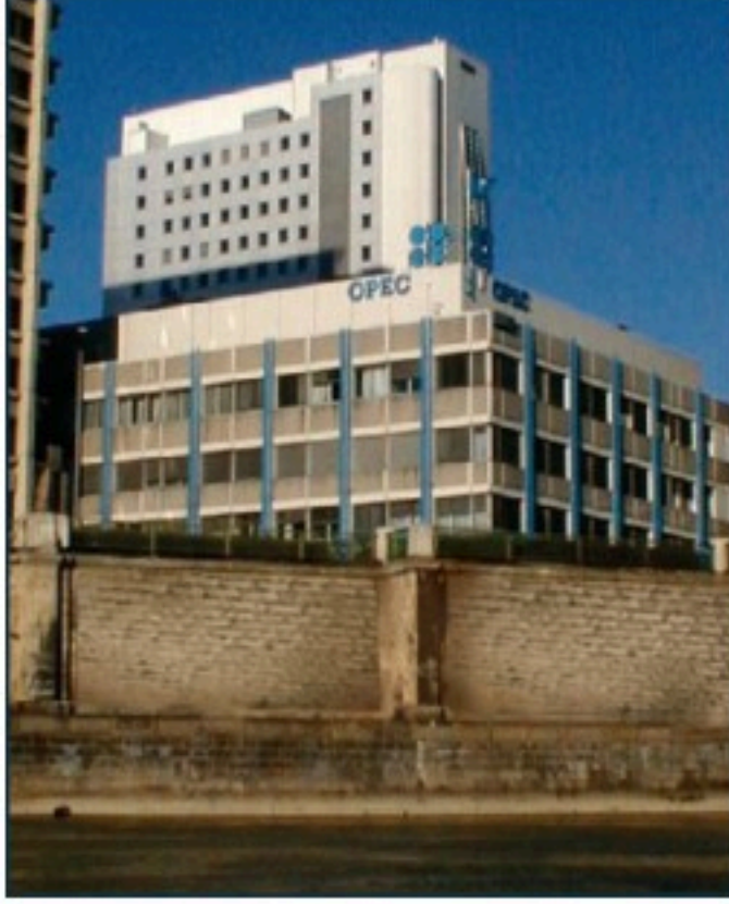
▲ مبنى منظمة أوبك في فيينا
