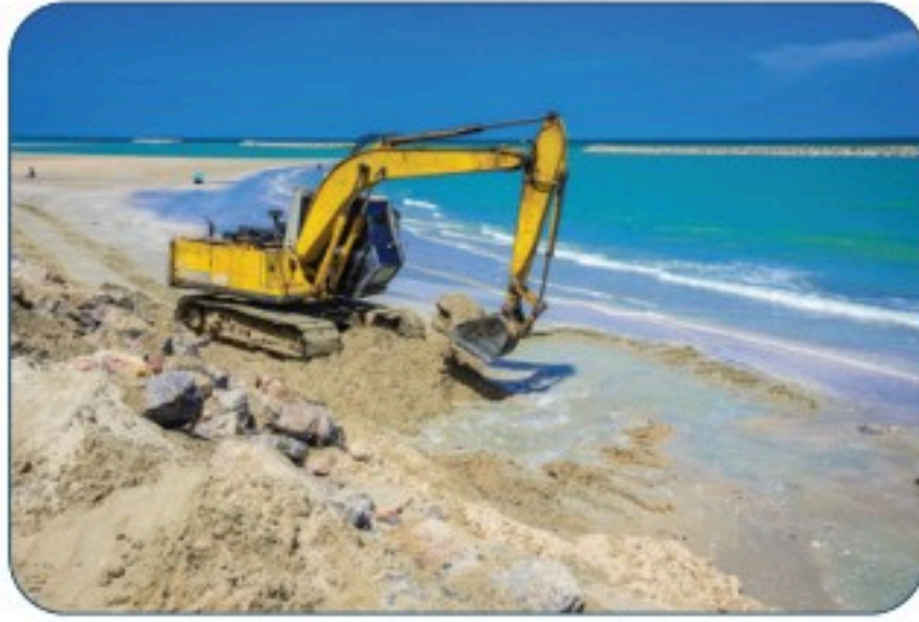
شكل 8-24 تجريف مياه البحر.
