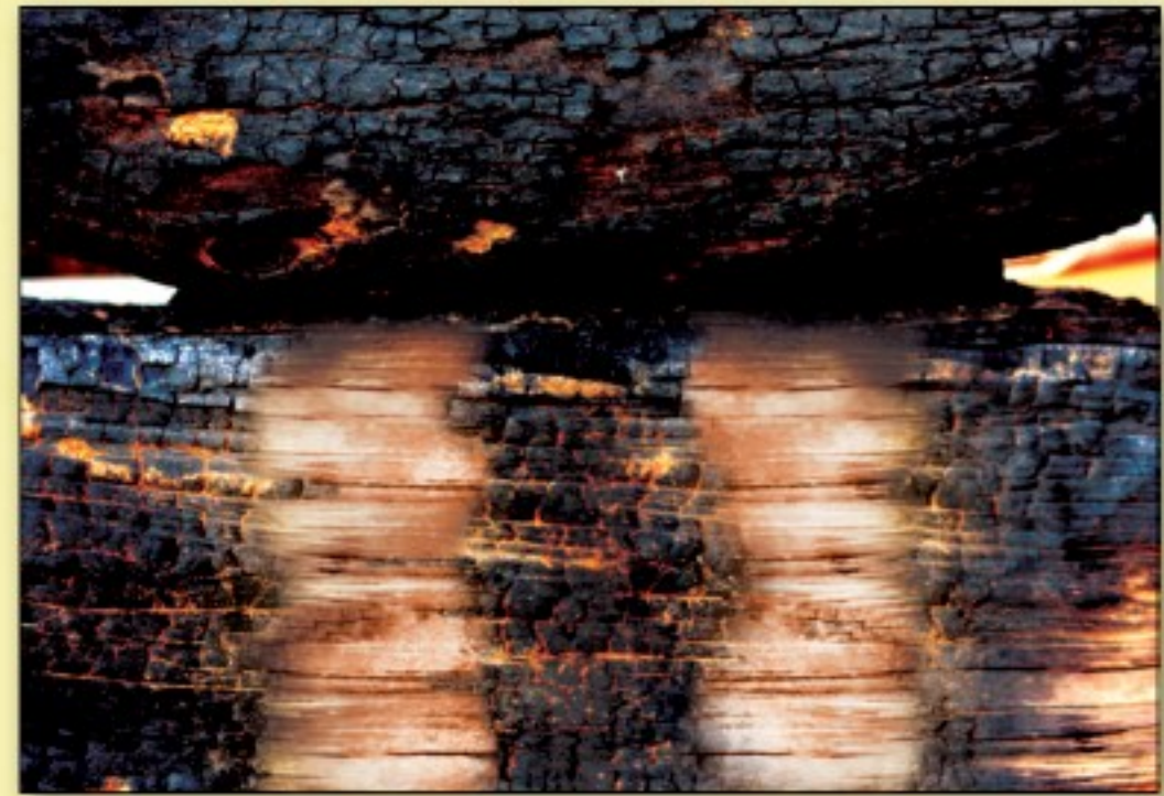
الشكل 1 المسرعات قد تسبب نمط الاحتراق المتهاوي.
