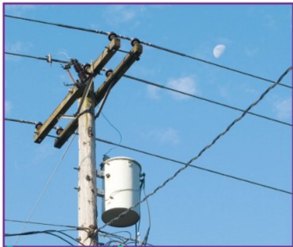
هناك أدواتٌ تُسمّى المحولاتُ تستعملُ المغناطيسيةَ لخفضِ تيارِ الكهربائيّ إلى قدرٍ مناسبٍ ليُستخدمَ في المنازل.
