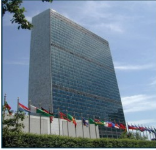
▲ مبنى هيئة الأمم المتحدة
