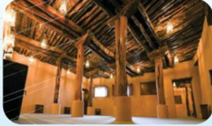
مسجد تاريخي بعد ترميمه
