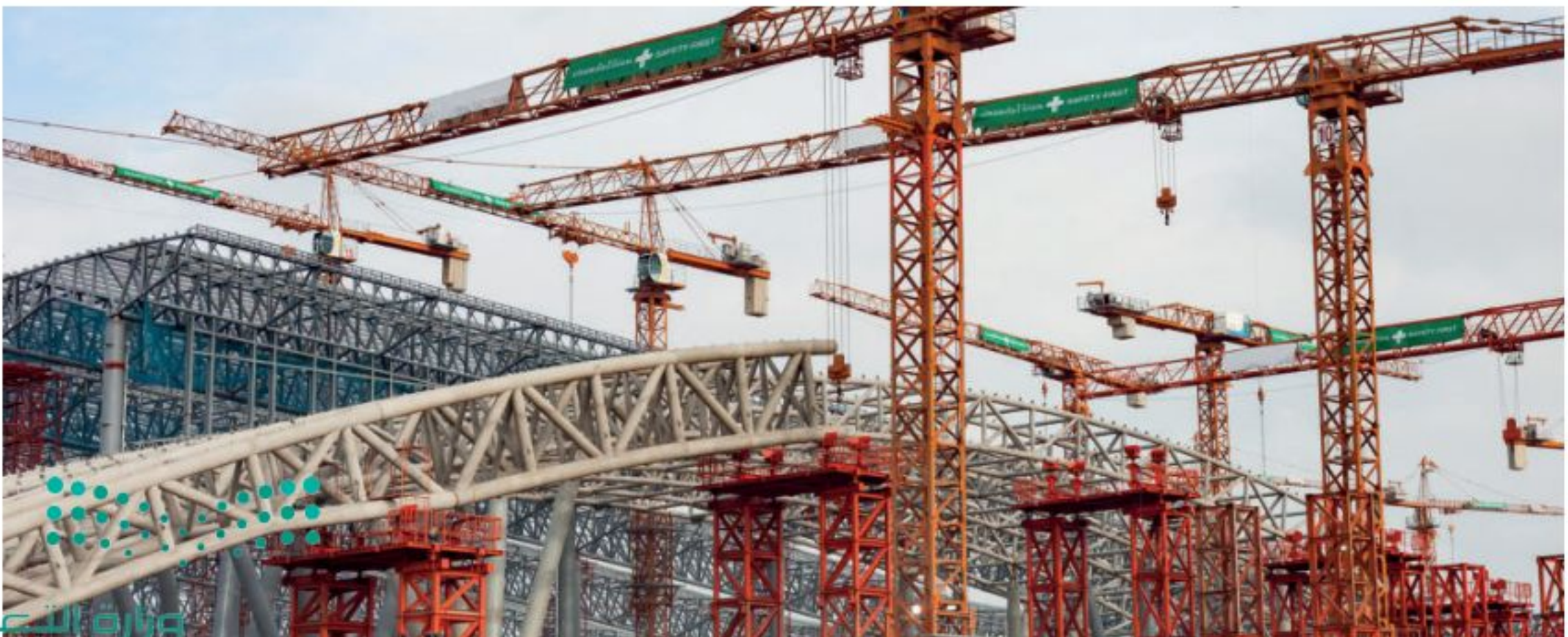
شكل 1.8: إنشاء قطار الأنفاق (المترو) في الرياض
