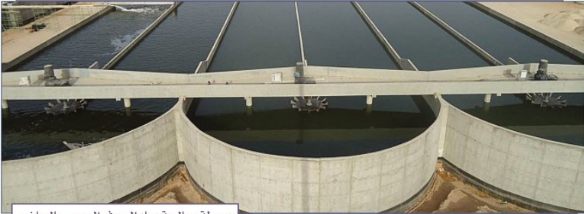
محطة معالجة مياه الصرف الصحي بالرياض
